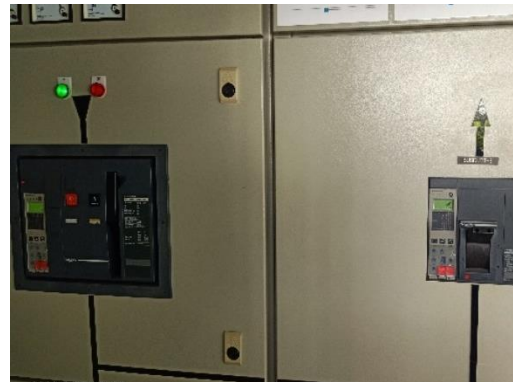
แผงจ่ายไฟหลัก (Main Distribution Board, MDB) อาคาร D และ อาคาร E
