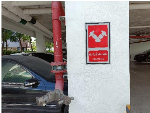
หัวรับน้ำดับเพลิง (Fire Department Connection) อาคาร D และ อาคาร E
