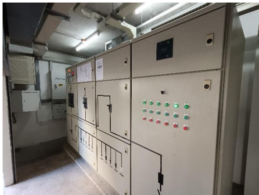
แผงจ่ายไฟหลัก (Main Distribution Board, MDB) อาคาร D และ อาคาร E
