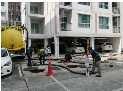
สูบน้ำทิ้ง ระบบบำบัดน้ำเสีย (ล่าสุด 12/10/65)
